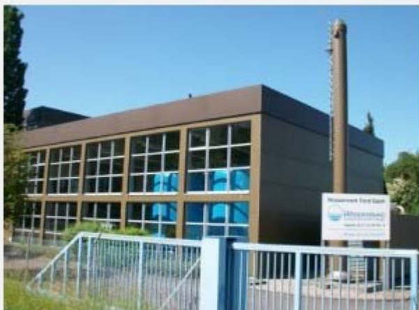
Wasserwerk Esloh (Bei Dedensen)
